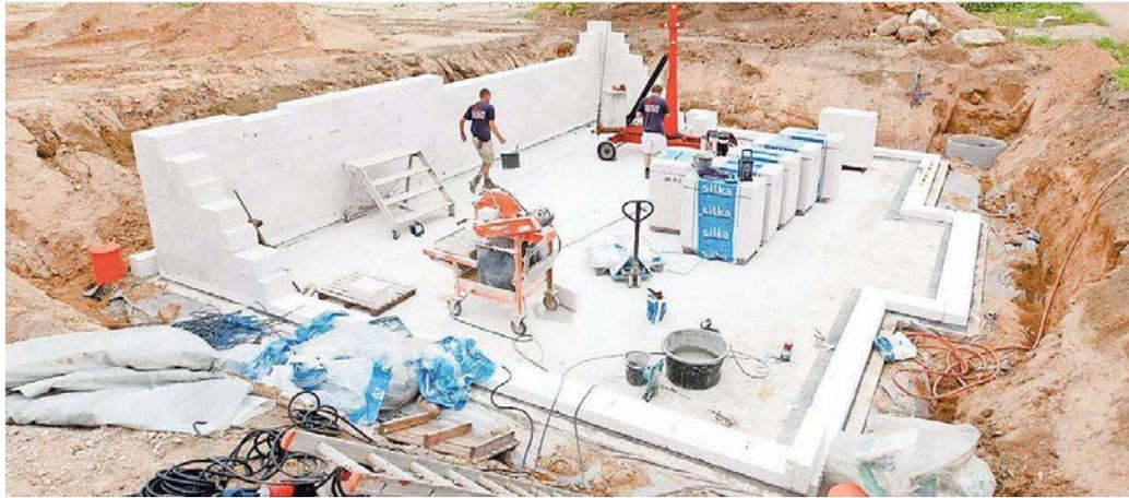
Bauherren sollten in der Baubeschreibung darauf achten, wie die Abwasserleitungen verlaufen sollen – damit die Bodenplatte später bei möglichen Reparaturen nicht wieder aufgerissen werden muss.
